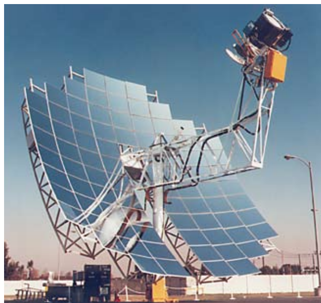
Figura B.6 - Impianto a concentratore a disco parabolico
