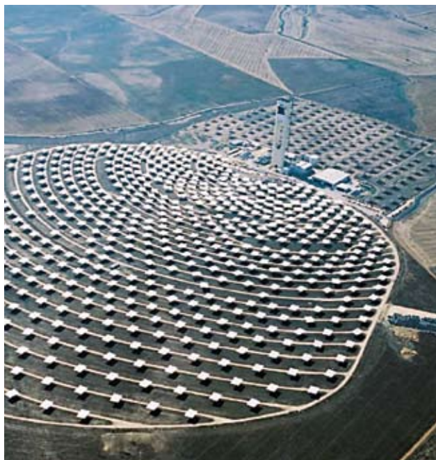
Figura B.8 - Impianto a ricevitore centrale
